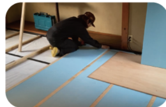
断熱材敷き込み
