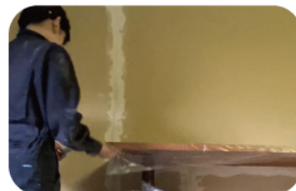
養生をする様子
