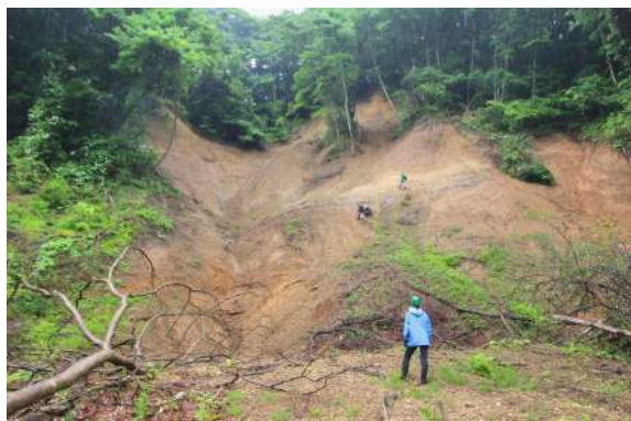
写-9 壁取り場（令和2年6月）
