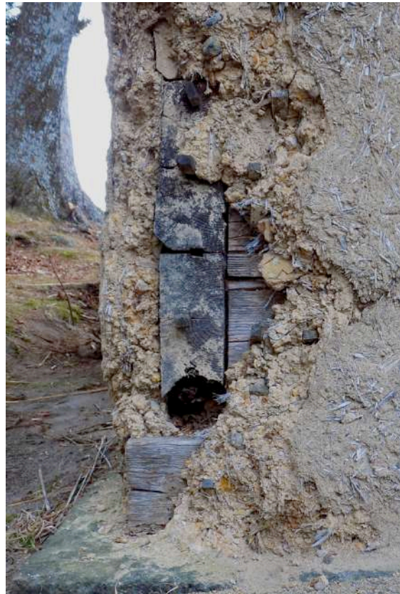
外壁隅部 井籠組と土壁（令和 2 年撮影）
