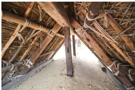
写-5 置屋根小屋組（西より）
