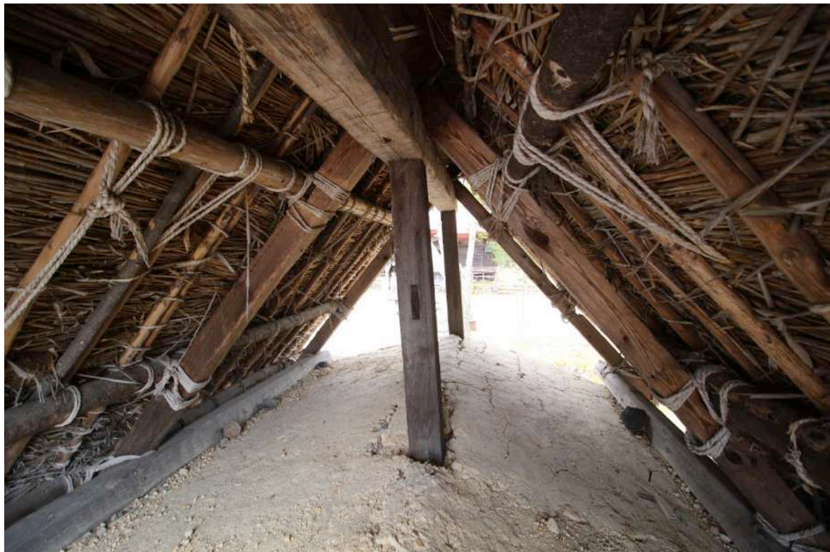
置屋根 小屋組（令和元年撮影）
