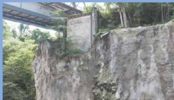
■コンクリート吹付工事が完了、中央は旧橋の橋台 撮影:令和5年8月28日
