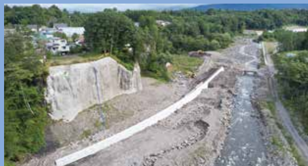
■コンクリート吹付工事が完了、護岸工事が行われている 撮影:令和5年9月23日
