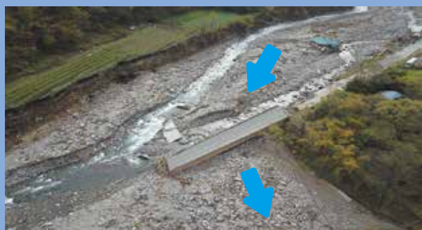
①鳴岩橋が落橋、川の流れが変わり、国道144号も流失 撮影:令和元年11月3日 矢印は災害前の水流
