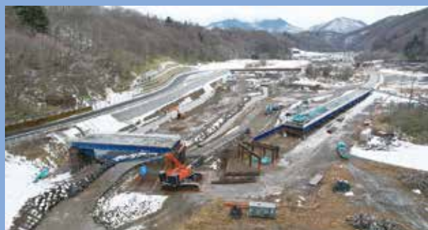
③仮設橋及び仮設道路の撤去工事 撮影:令和5年1月14日
