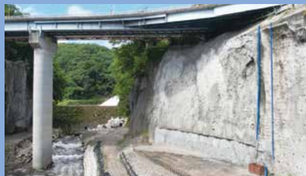
■護岸工事及び崖の崩壊防止工事を進行中 8月24日から片側通行 撮影:令和5年8月28日
