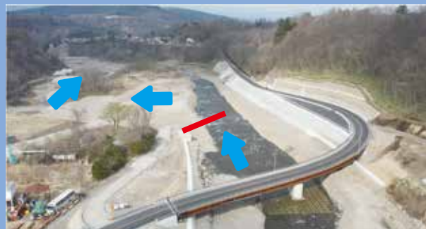
④吾妻川周辺の整地が完了し、3年5カ月を経て完了 撮影:令和5年4月2日 赤色の線は旧鳴岩橋の位置
