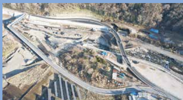
②令和4年12月10日、新たな鳴岩橋が完成し、通行を開始 撮影:令和4年12月10日
