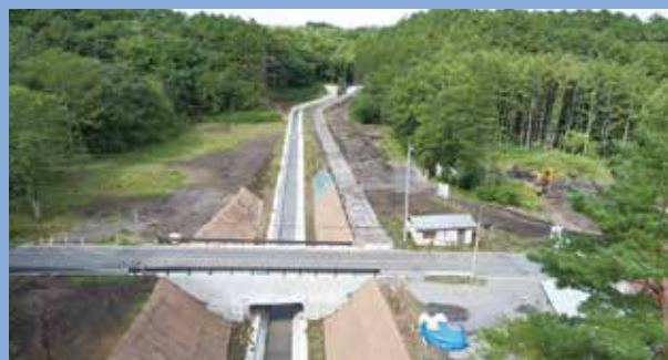
■県道東御・孺恋線の下を通過させる水路が完成 撮影:令和5年9月23日
