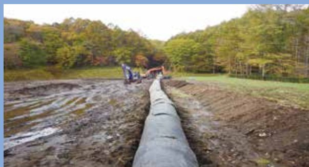
■新鹿沢の女塩淵沢(メガブチザウ)の沢水を緊急的にパイプラインで湯尻川に放流 撮影:令和元年10月26日
