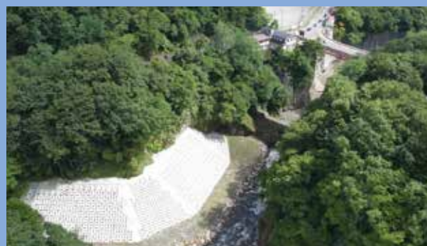
■復旧工事完了済 撮影:令和5年8月28日
