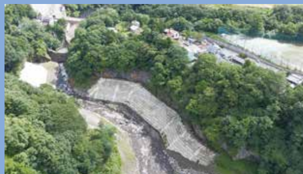
■復旧工事完了済 撮影:令和5年8月28日
