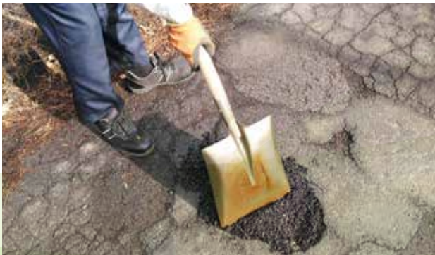
村道の穴埋め作業の様子
