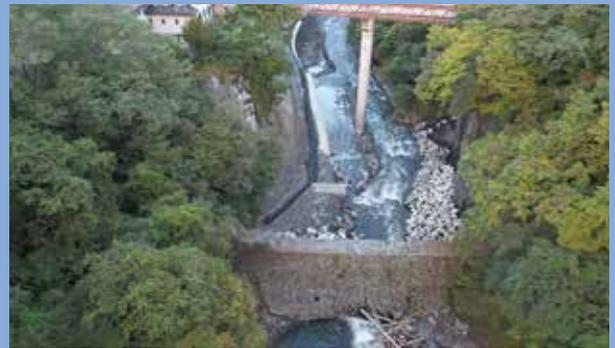
■右岸側崩落防止のためコンクリートブロックを設置
