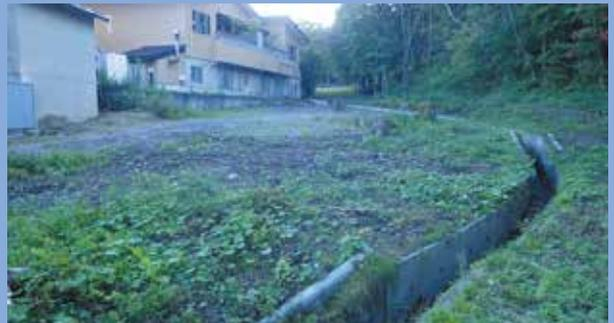
■流失箇所の埋め立てと水路の復旧工事 撮影:令和4年9月29日
