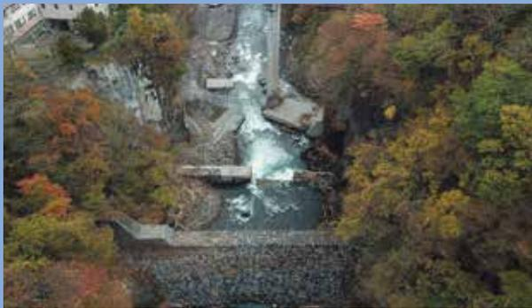
■孀恋橋上流側の砂防堰堤の底が抜ける被害
