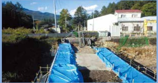
■県道の下を通過して湯尻川へ放流させる水路工事 撮影:令和4年9月29日
