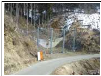
↑②対策工イメージ 強靱ワイヤーネット工
