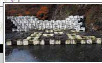
↓①対策工イメージ 床固工(コンクリートブロック)
