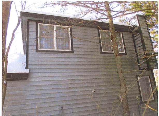
②建物(東側)
