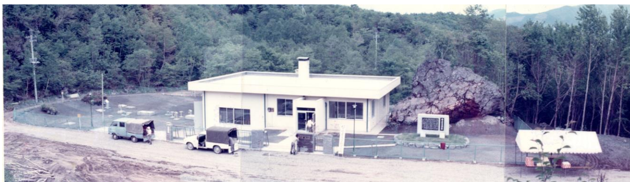
1972（昭和 47）年 第 1 浄水場管理棟
