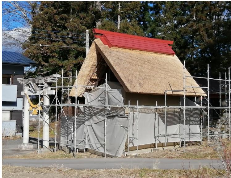
郷倉保存活用計画を策定しました。令和3年度より行われた修復工事では、土台から井籠組の板壁や小屋組み等を、損傷・汚損がないように注意しながらすべて解体し、部材ごとに可能な限り旧部材を使用し、破損部分は従前の仕様を踏襲し最小限の繕いを原則とし組み立てを行いました。この郷倉を次世代まで大切に守っていく試みとして、できる限り地域の手により創建当時の状況を再現するため、令和2年と3年の11月には2年にわたり地元鎌原区の皆さんによる茅刈体験を実施しました。そして、刈り取った地元産の茅を屋根の葺き替え材として用いました。また、今年9月には、鎌原地区にて採取した壁土を主に使用し、地元小中学生を中心に壁塗り体験を行い、多くのみなさんのご協力により12月には修復作業も完了の予定です。修復作業の完了した「鎌原の郷倉」をぜひ見に来てください。
