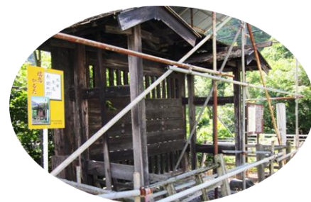
修復中の大笹関所跡
