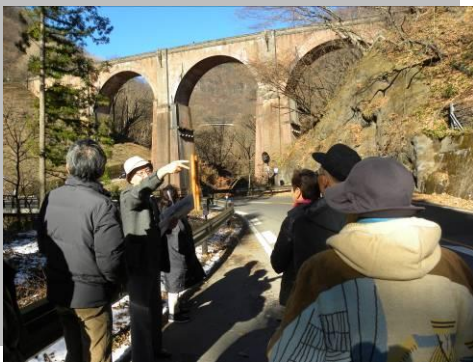
旧信越本線の碓井第3アーチ「めがね橋」 アーチ橋だ。
