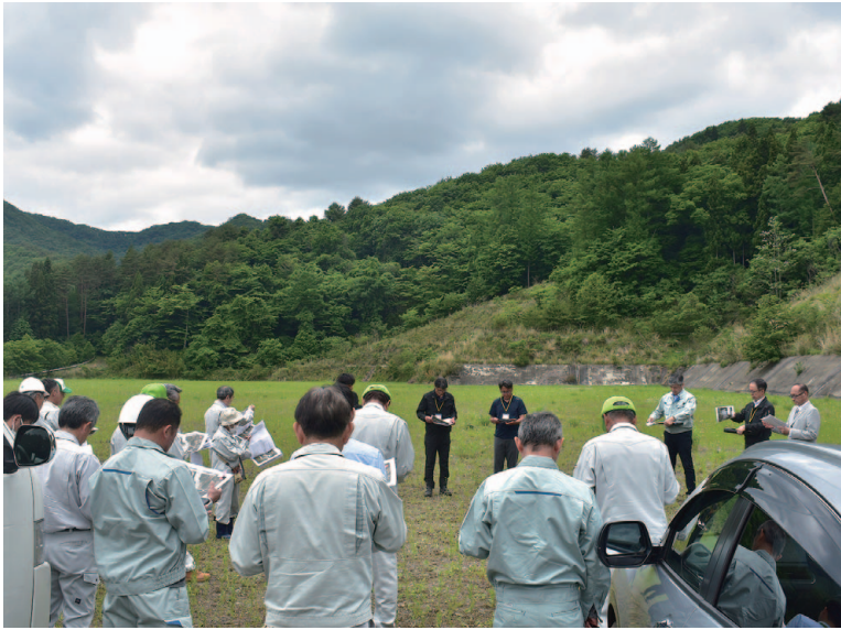
(仮称) 吾妻郡新ごみ処理施設建設予定地 (東吾妻町大柏木)
