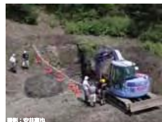
トレンチの掘削風景
